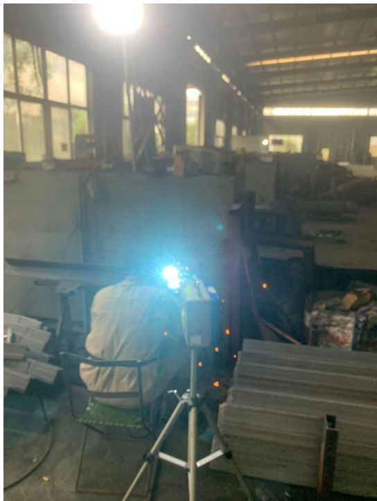
精加工车间电焊岗位
